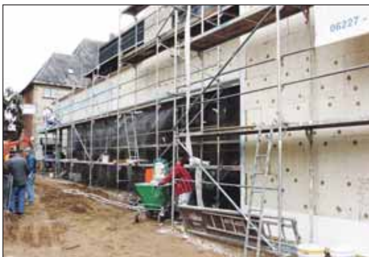
Das Wärmedämmverbundsystem der Außenwände wird mit Gewebe überspannt und mit einer ersten Lage Mörtel überzogen. Foto: zg
