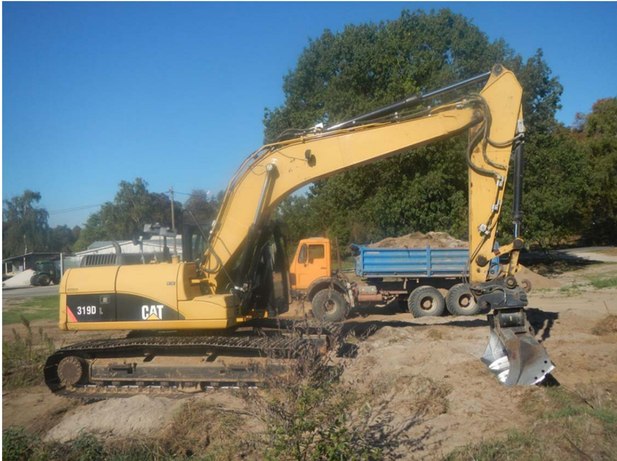
Abb. 2: Einsatzbeginn, Raupenbagger CAT 319D und Allradkipper MB 2635
